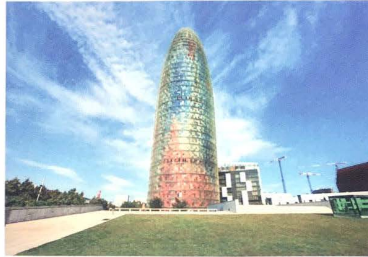
Torre Agbar, Barcelona. Foto: saiko3p (123RF)
